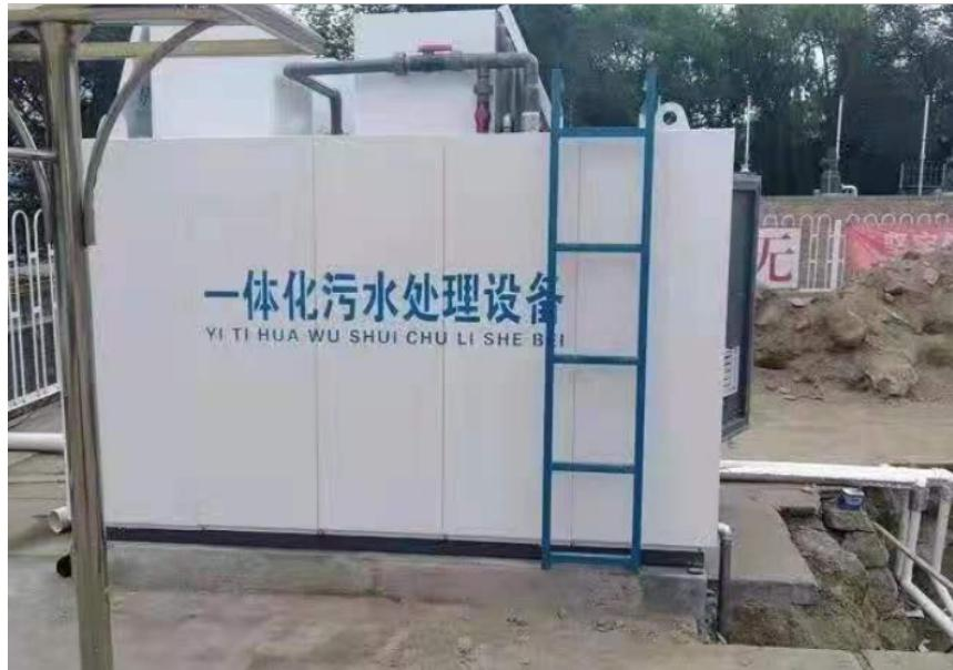
一体化废水处理设备特点：1. 抗冲击负荷能力强。接触氧化法的平均停留时间超过6小时；2. 具有脱氮除磷能力，可通过调整设备结构来处理工业废水、生活污水和城市污水；3. 接触氧化池的填料多为质量轻、强度高、物理化学性质稳定、比表面积大、生物膜附着力强、污水与生物膜接触效率高的组合软填料；4. 曝气器用于接触氧化池，使纤维束不断漂移，曝气均匀，微生物生长成熟，具有活性污泥法的特点；5. 出水水质稳定，污泥产量少，处理方便；6. 潜水泵可设置在设备中，减少工程投资。
